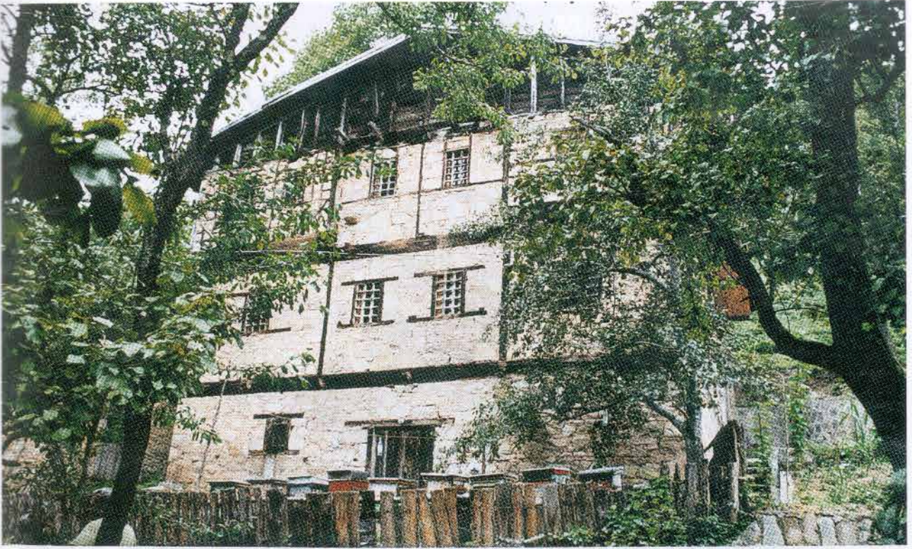
İkizdere' nin Yeşilyurt Mahallesiindeki (Manle) bu örnek evin mimarisi aynı olmakla birlikte, malzeme kullanımında bir farklılık olduğu gözlenmektedir. "Çatma" malzeme yerine taş duvarı uygulaması yapılmıştır.
