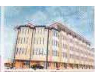
SA.U. Kütüphane İnşaatı
