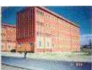
Erciyes Üni. Kütüphane İnşaatı
