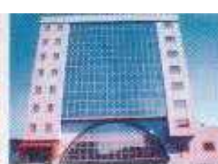
İgdaş Avcılar Hizmet Binası İnş.
