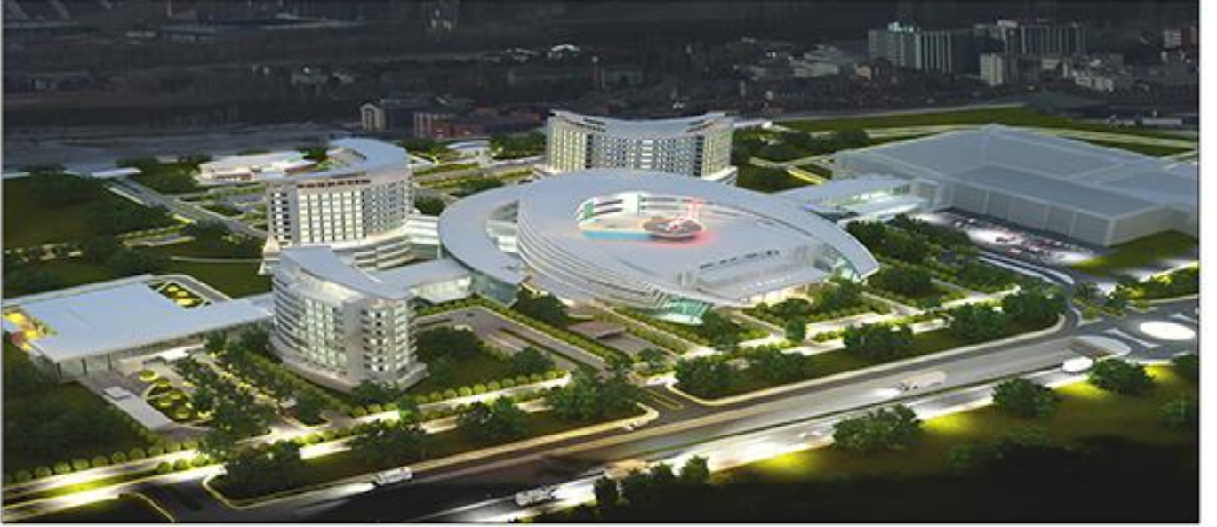
Erzurum 1900 Yataklı Sağlık Kampüsü İnşaatı İşi
