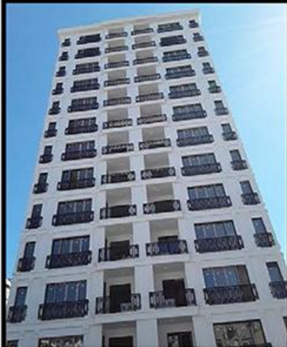
Demir Apt. Fener Yolu
