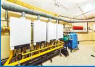
Kaskat sistemi uygulaması
