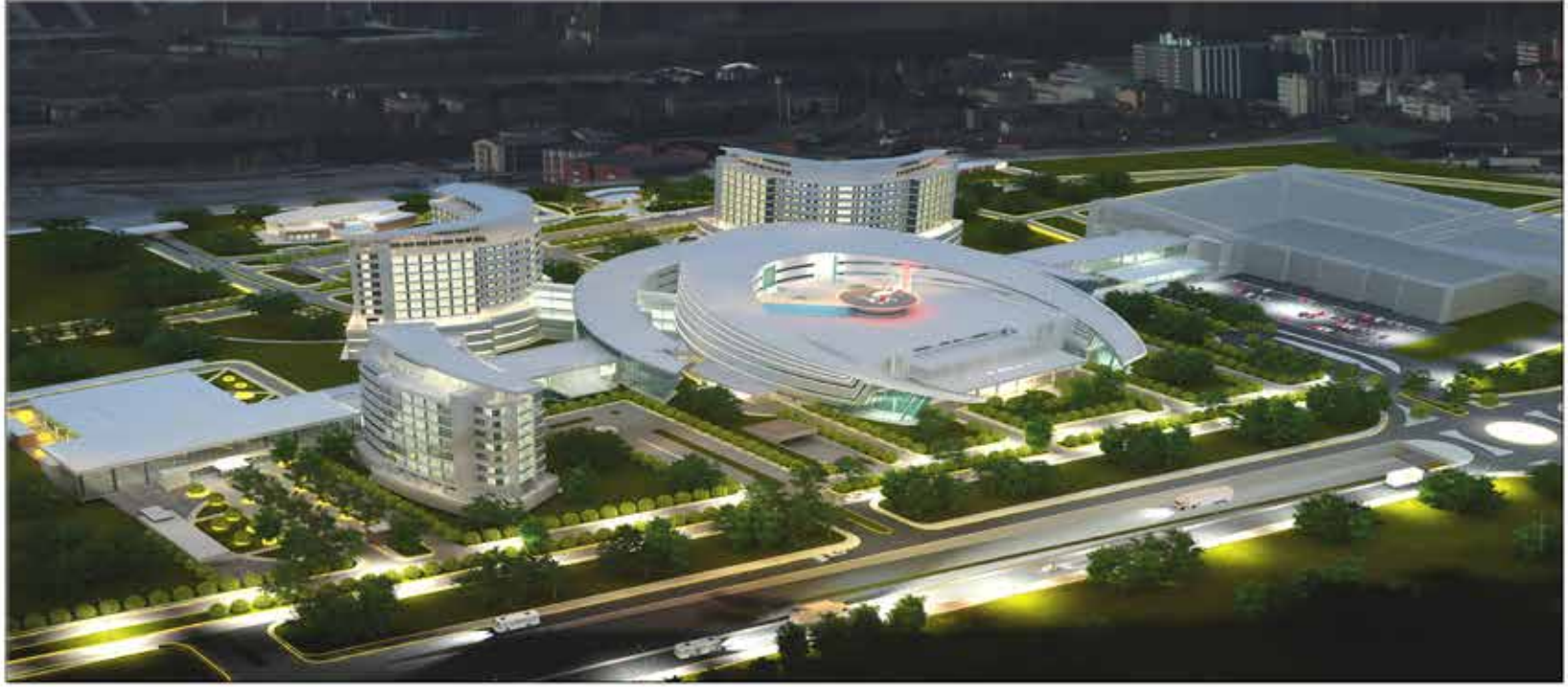
Erzurum 1900 Yataklı Sağlık Kampüsü İnşaatı İşİ
