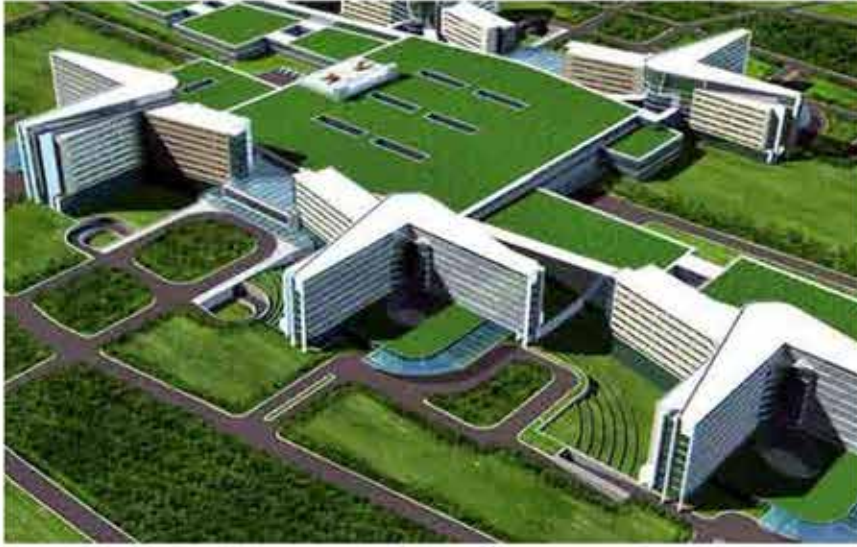
Bilkent Sağlık Kompleksi, Ankara, DİA İnşaat, Firestone TPO
