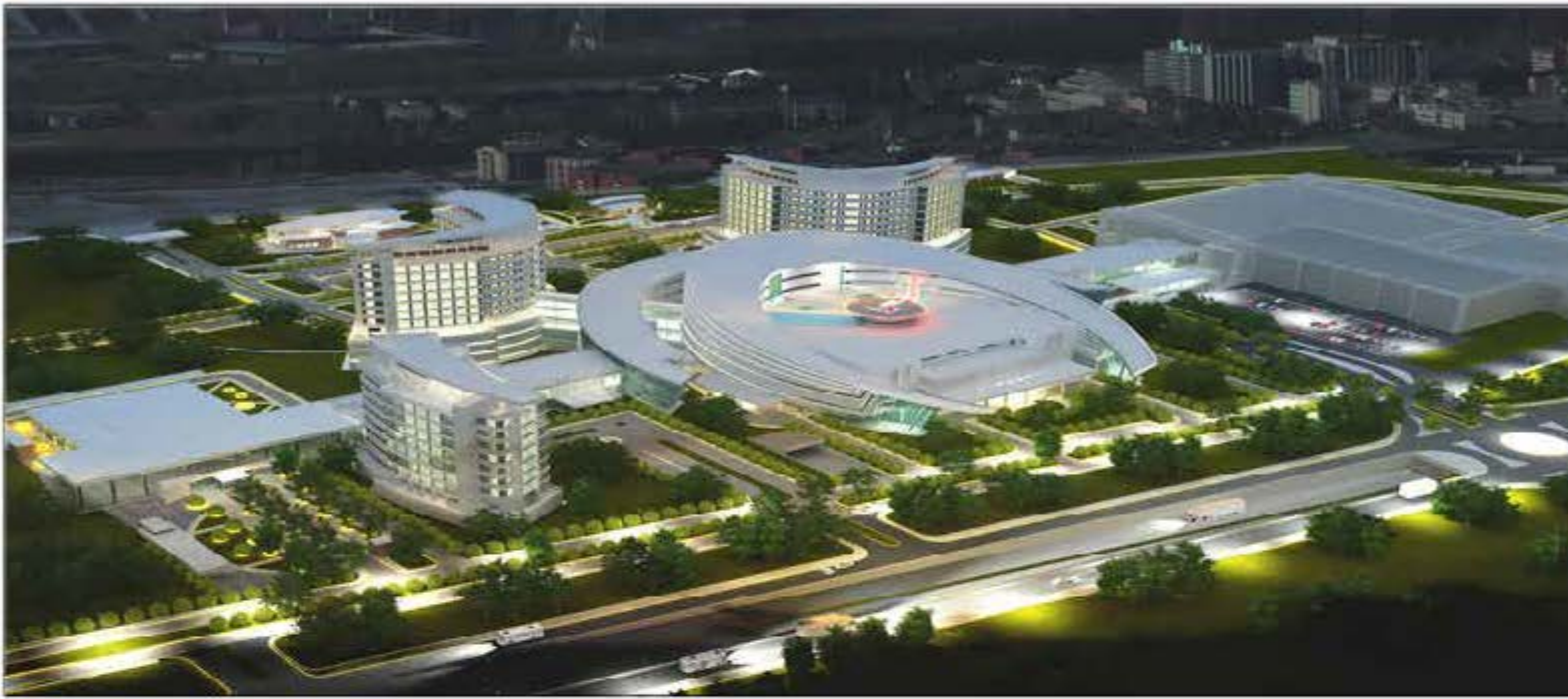
Erzurum 1900 Yataklı Sağlık Kampüsü İnşaatı İşi
