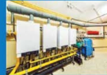
Kaskat sistemi uygulaması
