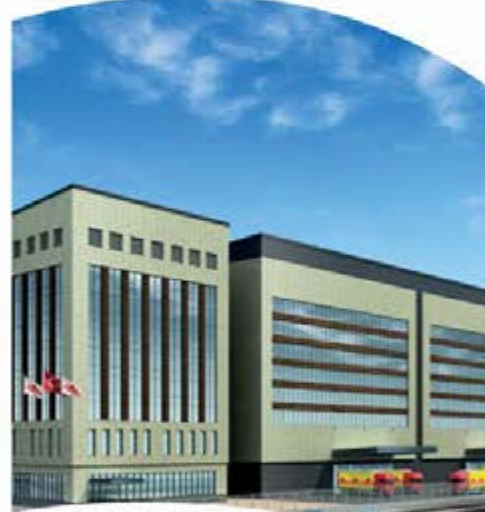
Çaykur Paketleme Fabrikası ve Otomasyon Tesisleri
