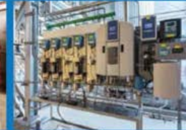
Alçak gerilim bina uygulaması
